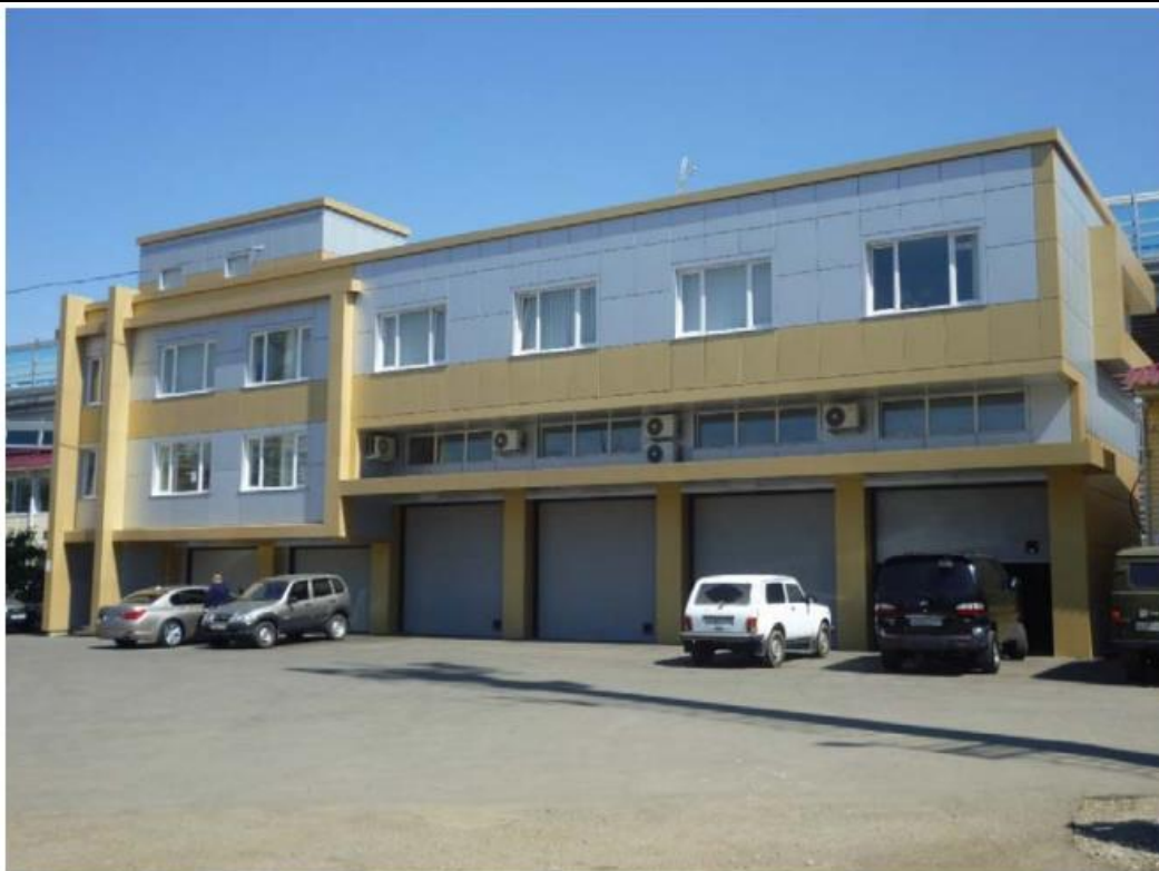
Рисунок 1. Здание службы механизации и транспорта (СМиТ) филиала ПАО «Кубаньэнерго» сочинской электрической сети в г. Сочи
