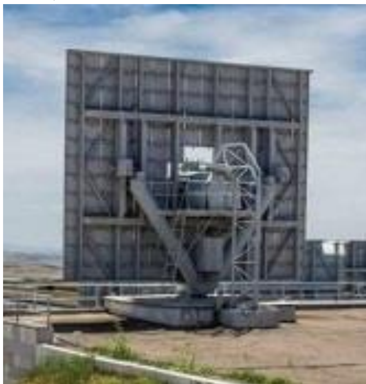
Фото.2 Конструкция управления гелиостата.
