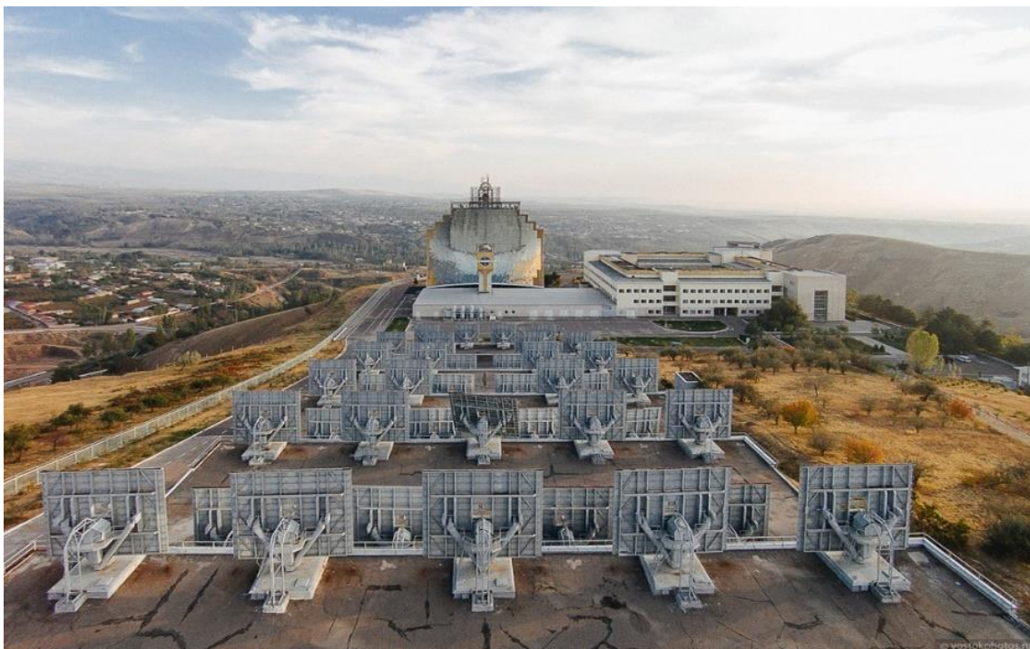
Фото.1 Большая солнечная печь мощностью 1 МВт в Узбекистане.
